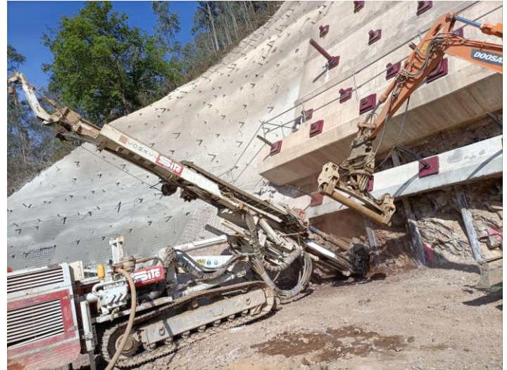
Imagen 1. Ejecución de anclaj
