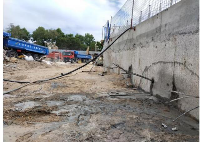
Imagen 4 y 5. Anclajes para contención y estabilización.
