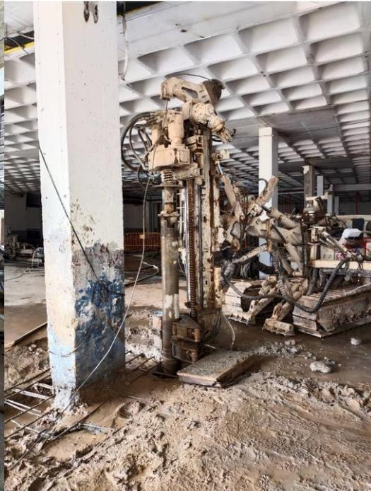
Imagen 4. Ejecución micropilotes en refuerzo cimentación existente.
