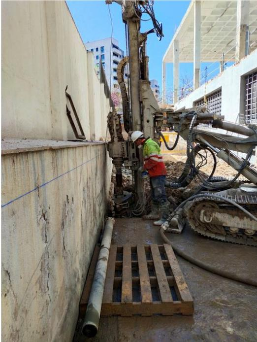
Imagen 3. Ejecución micropilote nueva cimentación.
