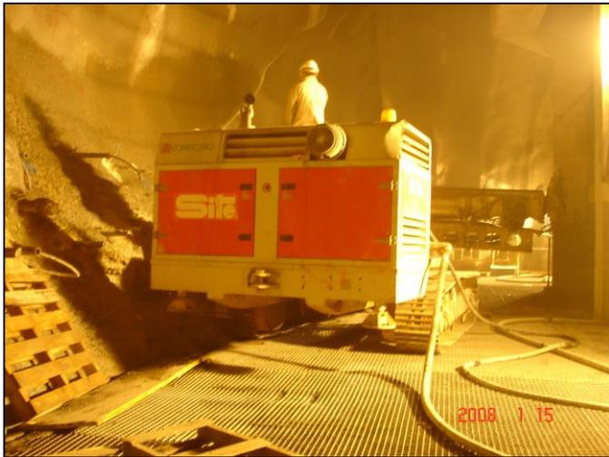
*Perforadora Comacchio Mc800 perforando sobre la cimbra montada en la boca 2.*
