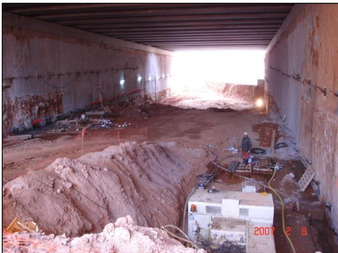
Visión parcial de la ejecución de las dos primeras filas de anclajes provisionales en la Estación de Can Roca (Terrassa).
