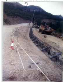
Para dotar de comportamiento unitario a la pantalla, se construyó una viga de atado de hormigón armado recogiendo los micropilotes, con sus correspondientes elementos de conexión de la armadura de los micropilotes con el hormigón.
