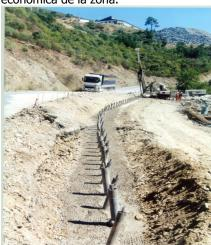
La obra debe realizarse en dos fases debido a la desproporción existente entre el volumen de coluvión real y el previsto en el informe inicial y
