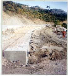
La misma viga sirvió de reparto de carga para anclar la pantalla en cabeza. Para ello se realizaron anclajes permanentes con barra tipo GEWI 650 mm. con equidistancias entre 1 y 2 m. y longitudes entre 14 y 25 m, con longitud de bulbo de 8 m. en el sustrato rocoso, y longitud libre variable en función de la profundidad de aparición de aquel en cada perforación.
