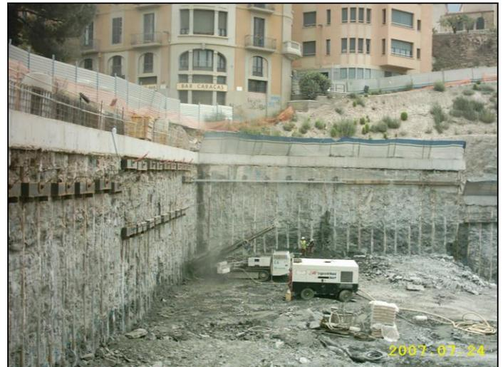
*Trabajos de perforación de anclajes provisionales para sostenimiento de las pantallas de micropilotes.*
