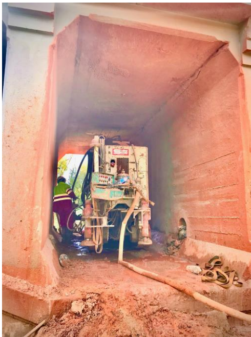
Imagen 2. Perforadora ejecutando micropilotes.
