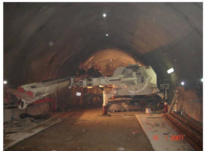
Equipo Casagrande PG115 perforando en el interior del túnel.
