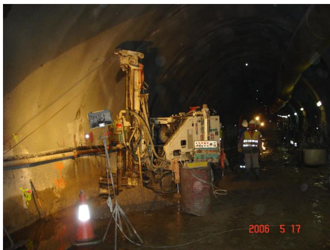
Equipo Casagrande M3 eléctrico perforando en el hastial del túnel.
