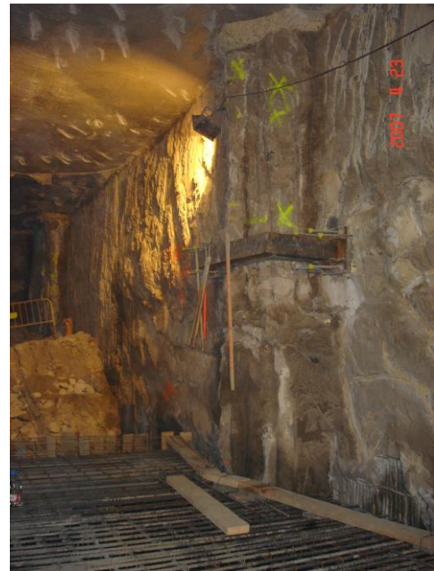
Junta de pantalla después del tratamiento.
