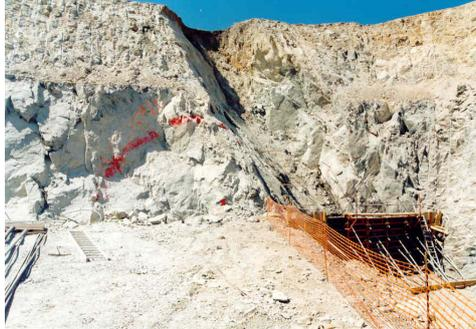
Los paraguas están compuestos por micropilotes de 150 mm. de diámetro de perforación y armaduras tubulares de  $\phi_{ext}/\phi_{int}$  89/75 mm., de acero de calidad N-80 y aplicación original *Tubing*, de fabricación tipo *seamless tube* (sin costuras), sin mecanización posterior, con uniones originales macho-macho con ligero ensanche de sección, con manguito exterior grueso incorporado, manteniendo en las uniones las características mecánicas de una sección normal.
