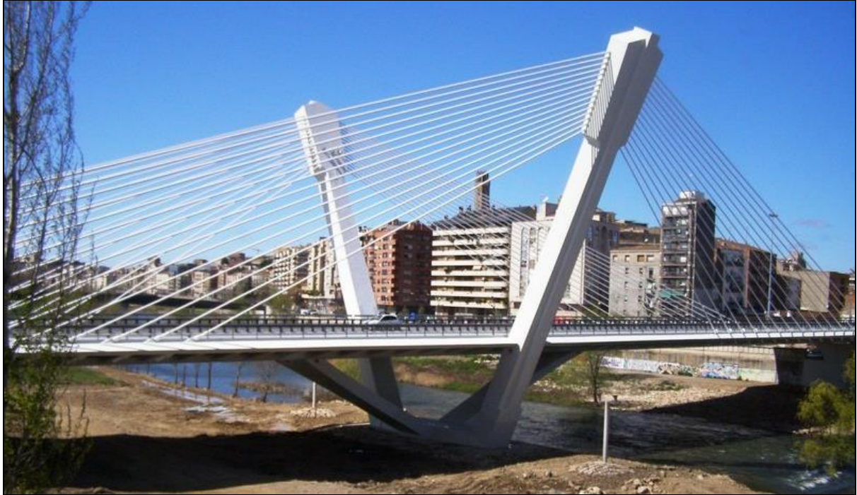
Puente sobre el río Segre en Lleida acabado.
