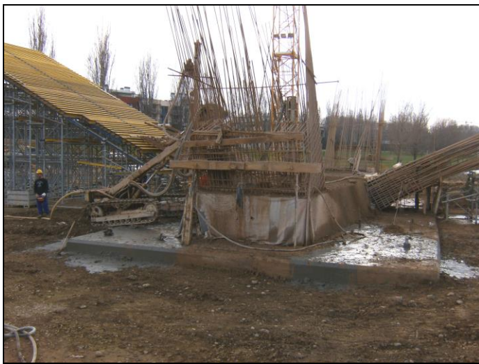
Trabajos de perforación en la zapata central.
