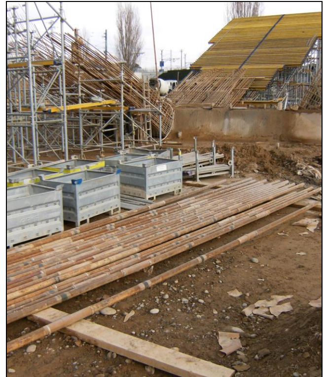
Tubos manguito metálicos utilizados en la inyección.
