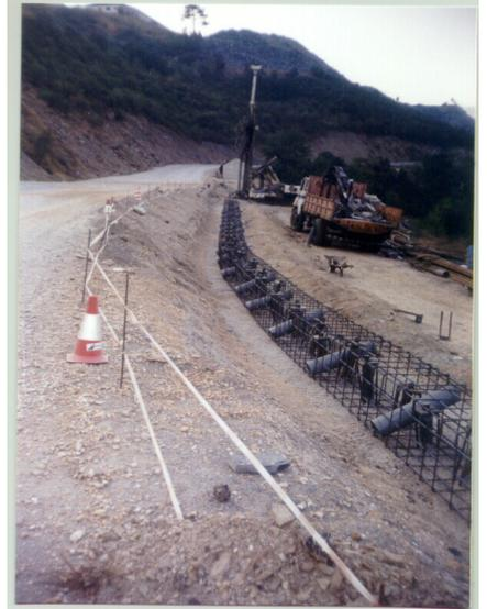
Para dotar de comportamiento unitario a la pantalla, se construyó una viga de atado de hormigón armado recogiendo los micropilotes, con sus correspondientes elementos de conexión de la armadura de los micropilotes con el hormigón.
