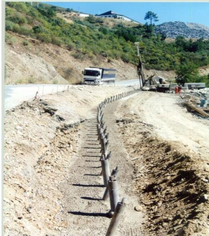
La obra debe realizarse en dos fases debido a la desproporción existente entre el volumen de coluvión real y el previsto en el informe inicial y en proyecto.
