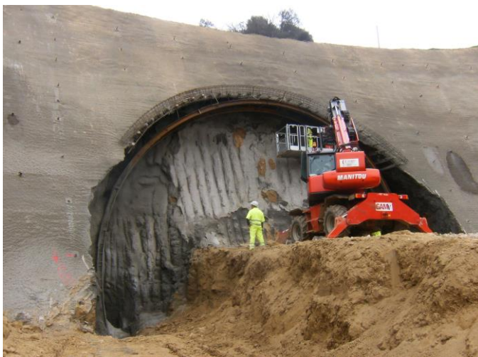
Emboquille Sur Túnel Llogaia (ejecución viga de atado del paraguas de micropilotes).
