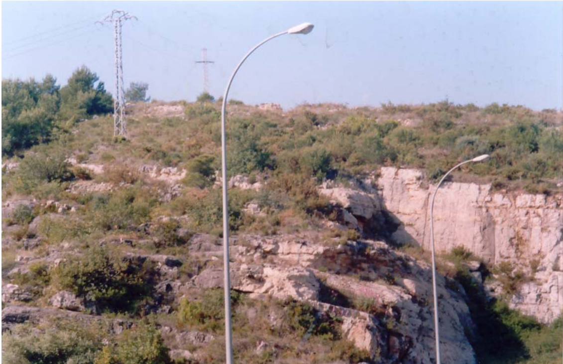
Foto 1. Aspecto del terreno natural al Este de la boquilla
