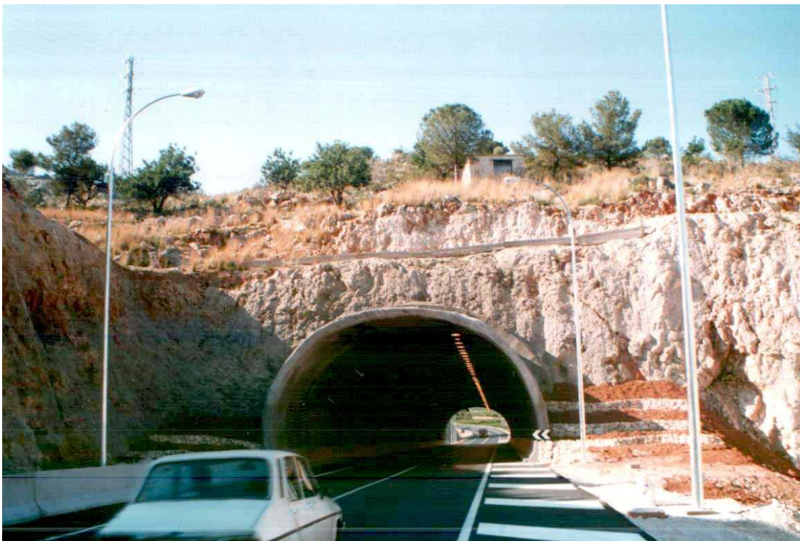
Foto 2. Boca Norte del Túnel 2 de Gandia en servicio
