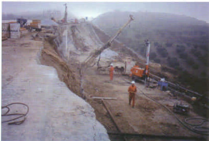
En un plazo de dos meses se ejecutan setenta metros lineales de muro en la parte inferior del escarpe y sesenta metros lineales de viga en la calzada de la autovía con un total de 4.500 ml de micropilote que permiten realizar los rellenos necesarios para acondicionar el carril derecho de la calzada de la autovía, restableciendo el tráfico el 15 de Marzo de 2001.
